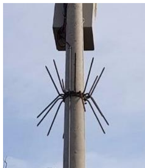
Ilustración 6 Sistema contra robo en postes
