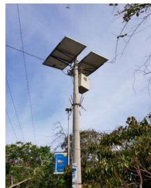
Ilustración 4 Sistema de energía solar para funcionamiento
