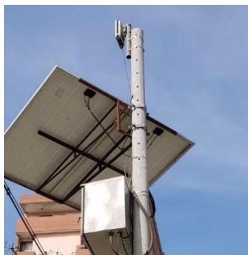
Ilustración 3 Access point principal y secundario
