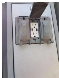
Ilustración 8 Sistema de protección para uso indebido de la corriente del tótem y carga de dispositivos electrónicos de comunicaciones
