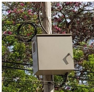
Ilustración 5 Gabinete de networking
